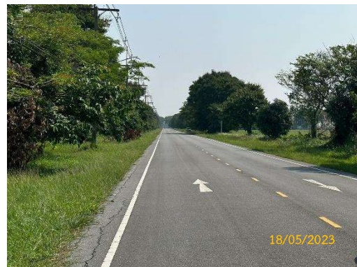
รูปที่ 3-22 บริเวณไหล่ถนนรอบท่าอากาศยานที่อยู่ระดับเดียวกับผิวถนน
