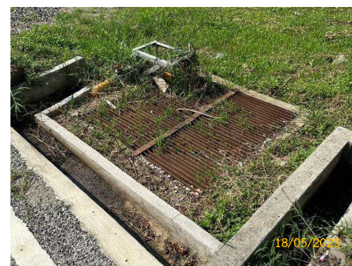
รูปที่ 3-15 รังระบายน้ำรอบอาคารพักขยะ
