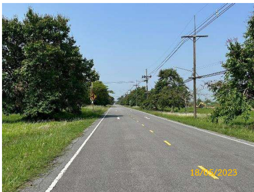
รูปที่ 3-22 บริเวณไหล่ถนนรอบท่าอากาศยานที่อยู่ระดับเดียวกับผิวถนน
